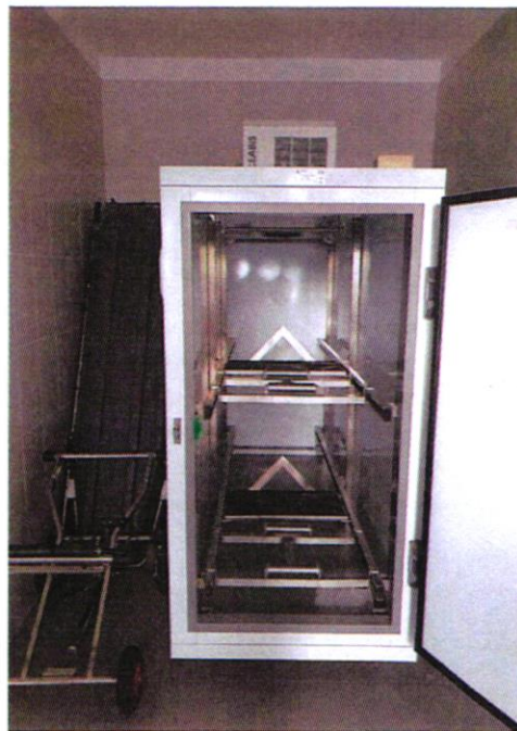
Slika 5: Hladilna komora za 2 osebi z urejenim prezračevanjem, z ustrezno antibakterijsko osvetljavo in prostor za delo s pokojniki
